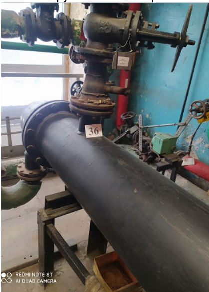
35 Подогреватель пароводяной ПП 2-9,5-0,7-2
