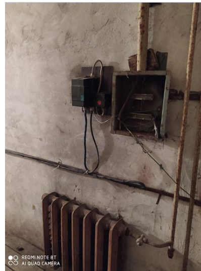
34.2 Станция управления защиты насосов СУЗ-10
