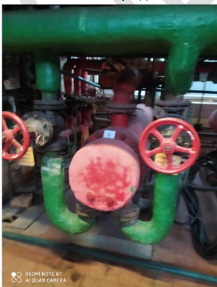
6 Подогреватель пароводяной ПП 2-17-7-2
