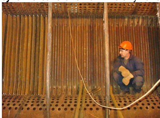
Рисунок 26. Замена конвективного пучка котла
