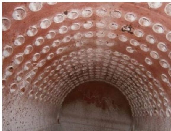
Рисунок 25. Вид агрегата изнутри
