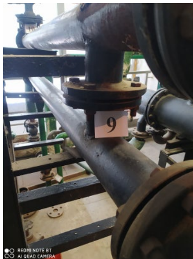
9 Водоподогреватель ВВП 07-114-2000
