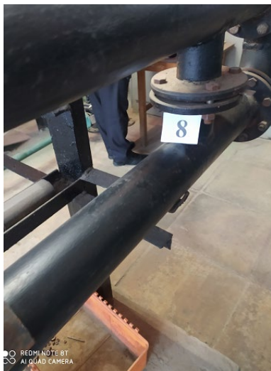
8 Водоподогреватель ВВП 07-114-2000
